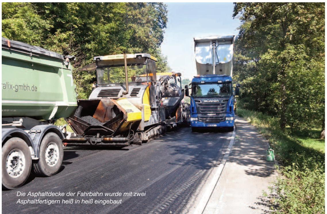
Die Asphaltdecke der Fahrbahn wurde mit zwei Asphaltfertigern heiß in heiß eingebaut
