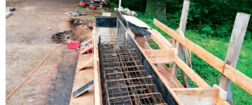
Alle hohl liegenden und losen Teile im Bereich der Kappen wurden abgebrochen. Nach Vorbehandlung des Untergrundes wurden Verbundanker eingebaut, um den neuen Beton im Bestand zu verankern. Im Bild ist der Einbau der Kappenbewehrung zu sehen.
