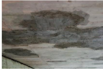
... und mit PCC-Mörtel reprofiliert. Zuletzt wurde ein Oberflächenschutzsystem OS C aufgebracht, um eine erneute Karbonatisierung zu verlangsamen.
