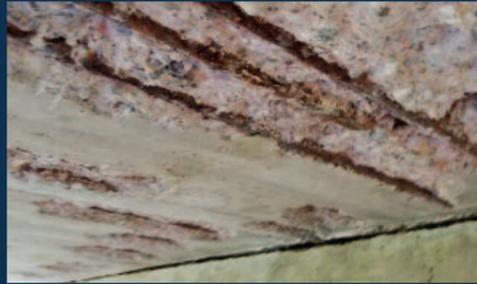
Zahlreiche Abplatzungen und freiliegende Bewehrung. Alle losen Teile wurden entfernt, der Untergrund wurde abgestrahlt, mit einer Haftbrücke versehen ...
